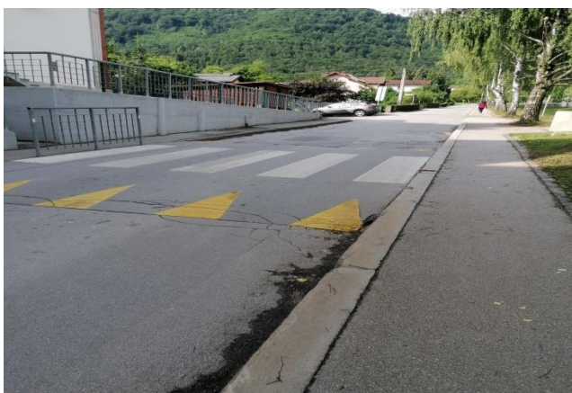
Slika 6: Označen prehod in dvignjena ploščad za umirjanje prometa za prečkanje ceste s Športne dvorane proti OŠ Pod goro (Tattenbachova ulica). Urejen pločnik za učence, ki prihajajo s Tattenbachove ulice.
